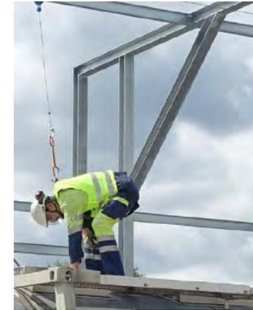
Sicheres Arbeiten in der Höhe an stationärem Einsatzort
