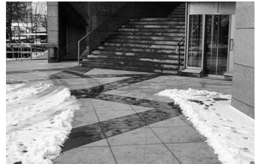
Bild 2: Von Schnee und Eis geräumter Gehweg.
