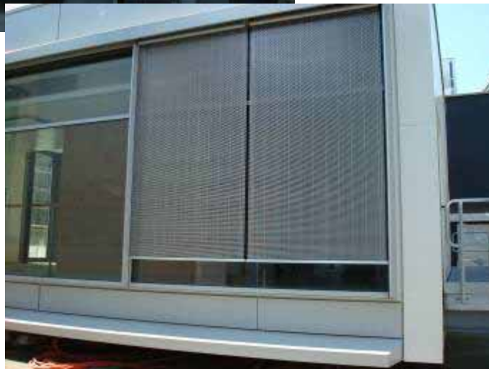
Blendschutz (Innenstoren aus Metall)
