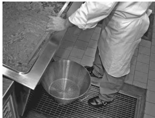
Bild 1: Bodenebene und rutschhemmende Roste verhindern Ausrutsch- und Stolperunfälle.
