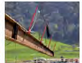
3 Durch Vormontagen die Arbeitszeit mit Anseilschutz möglichst kurz halten.
