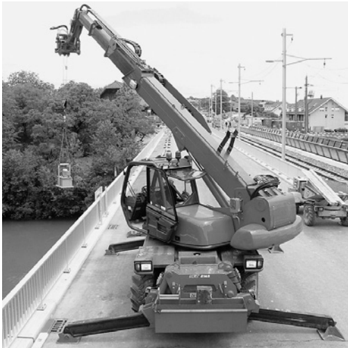
Bild 5 Fahrzeugkran: Teleskopstapler mit Seilwinde
