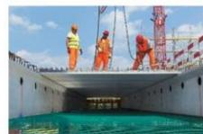
Éléments préfabriqués en béton
