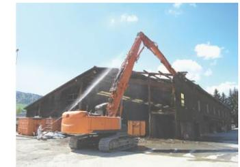
Déconstruction d'ouvrages amiantés avec une pelleuse
