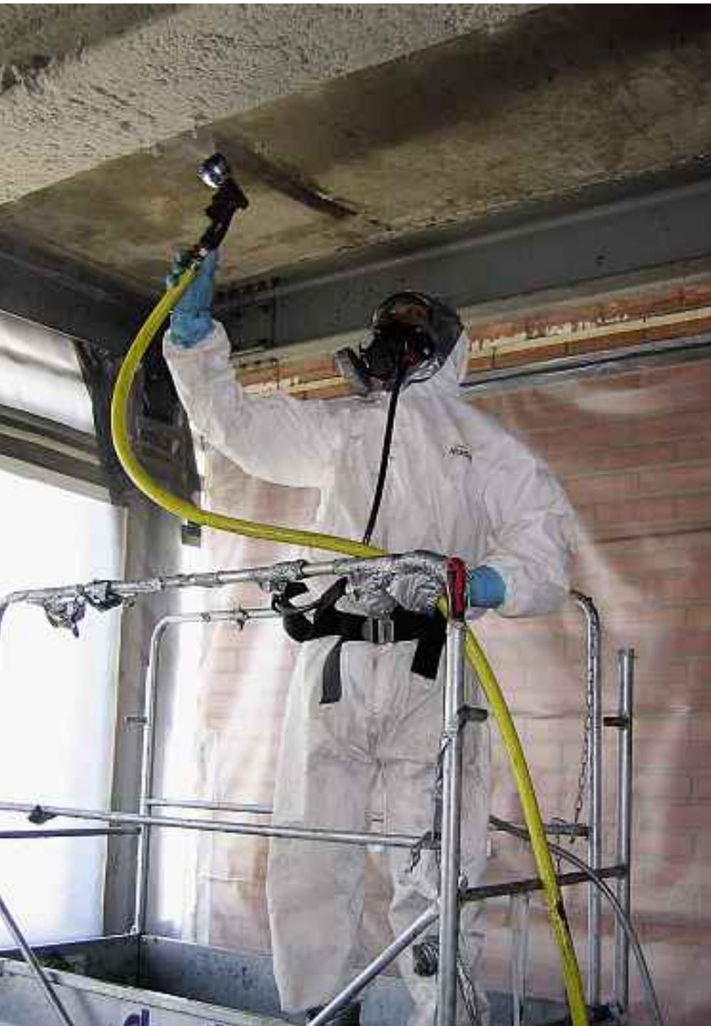
*Bonifica da amianto con tecnica di rimozione a umido, operatore con respiratore a presa d'aria fresca.*
