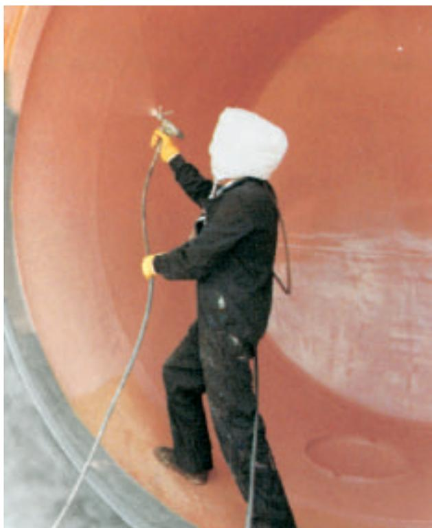
Applicazione di un rivestimento a spruzzo in resina epossidica ad una cisterna
